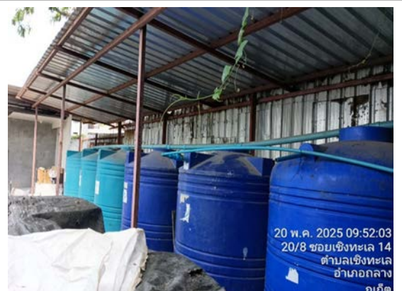
รูปที่ 3-33 ถังเก็บน้ำสำรองขนาดไม่น้อยกว่า 20.00 ลบ.ม.
