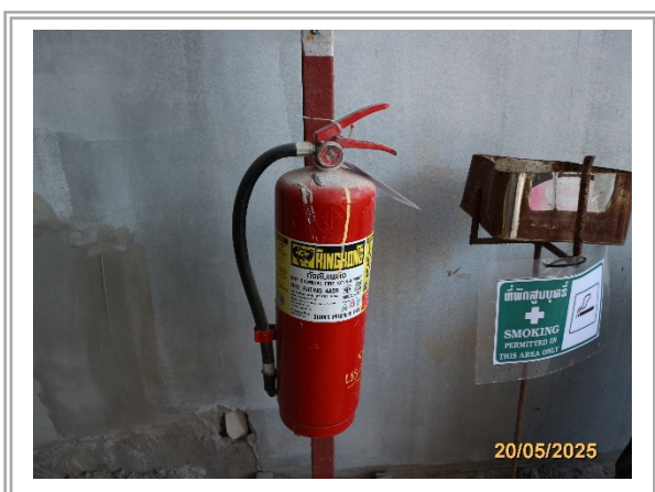
รูปที่ 3-54 ถังดับเพลิงเคมีชนิดแห้ง
