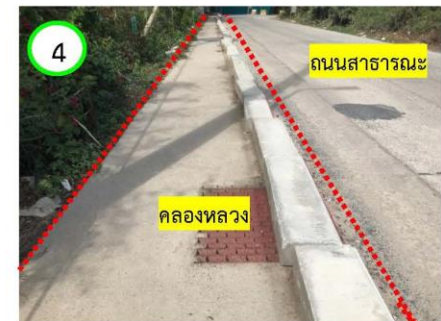
ทิศตะวันออก ติดต่อกับ คลองหลวง (มีสภาพเป็นท่อลอดเหลี่ยมชนิด ค.ส.ล.แบบปิดริมถนนสาธารณะกว้าง 2.40 เมตร) ถัดไปเป็นซอยเชิงทะเล 14 มีความกว้างรวมเขตทาง 6.90 เมตร
