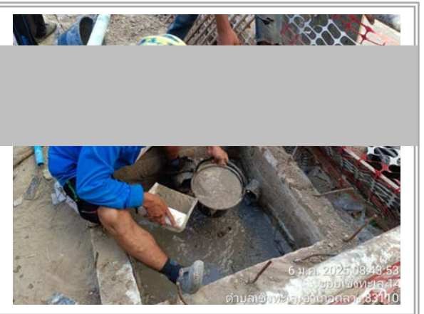
รูปที่ 3-27 การทำความสะอาดและขุดลอกบ่อดักดินตะกอน
